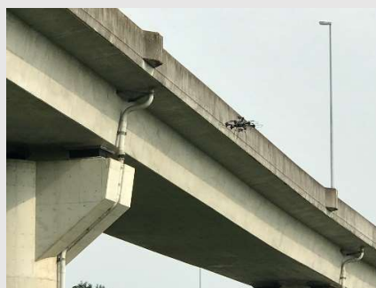
▲写真Ⅱ-2-11 高架橋におけるドローン点検
