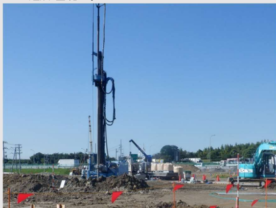
●造成・基礎工事
