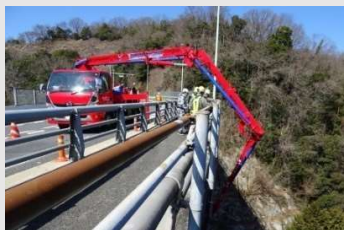
▲写真Ⅱ-2-11 コンクリートポンプ車を活用した点検ロボットによる橋梁・路面点検
