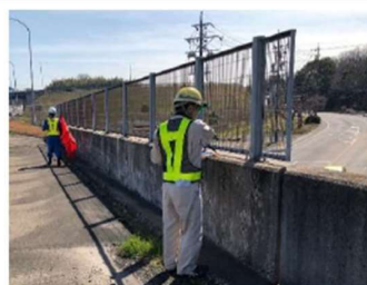
【道路施設定期点検実施状況】
