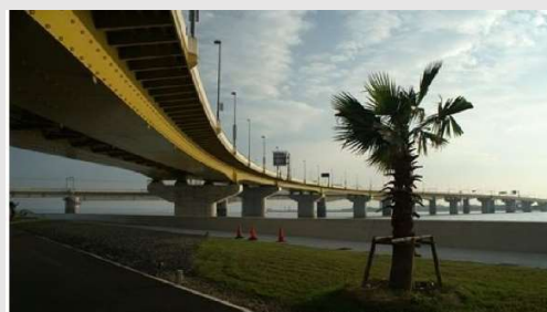
▲写真 I -4 中部国際空港連絡道路
