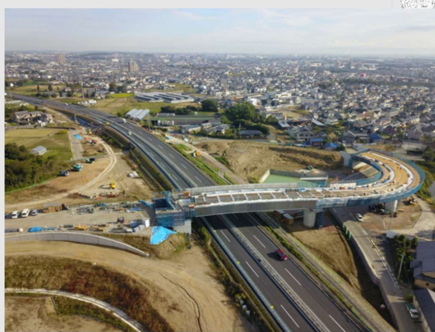
▲写真 II-3-1 工事状況全景
