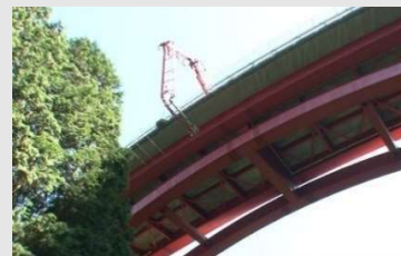
▲写真Ⅱ-2-11 コンクリートポンプ車を活用した点検ロボットによる橋梁・路面点検
