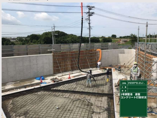
●調整池築造工事
